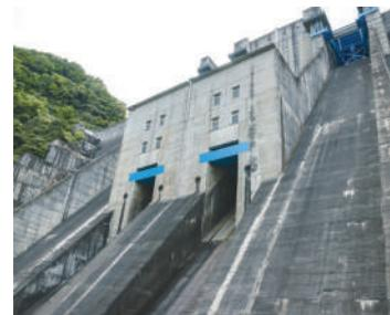
洪水の調節により都市と市民の命、財産を守ります。大雨時には、上流から流れてくる大量の水を一定量ダムに貯め込み、残りを下流に流します。
