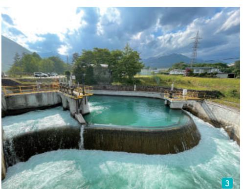
大町市の暮らしを支える北アルプスの雪解け水。水温が低すぎて農業用水には不向きと言われた水を有効利用するため、昭和29年から運用されているのが、灌漑施設を組み込んだ水利システムです。取水口となる鹿島槍ヶ岳の小冷沢から下流の広津発電所までは全長36Km、高低差は700m。本プログラムでは、水害対策などの役割も併せ持つ施設の見学を通じ、未来の水循環を考えます。
