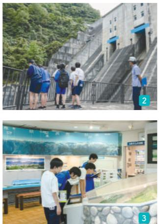
大町ダムは、貯水池からの水圧をダム自体の重さで支え、貯水機能を果たすよう造られた「重力式コンクリートダム」と呼ばれるタイプのダムです。巨大なコンクリートの塊に見える外観ですが、内部にはダムとしての機能を果たすため、さまざまな装置や機器が備えられています。プログラムでは、発電所とダムの見学を実施。建設の背景から暮らしとの関わりまで、細かに学ぶことができます。
